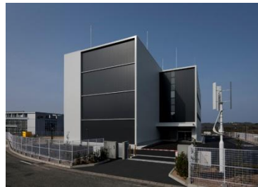
岡山データセンター
